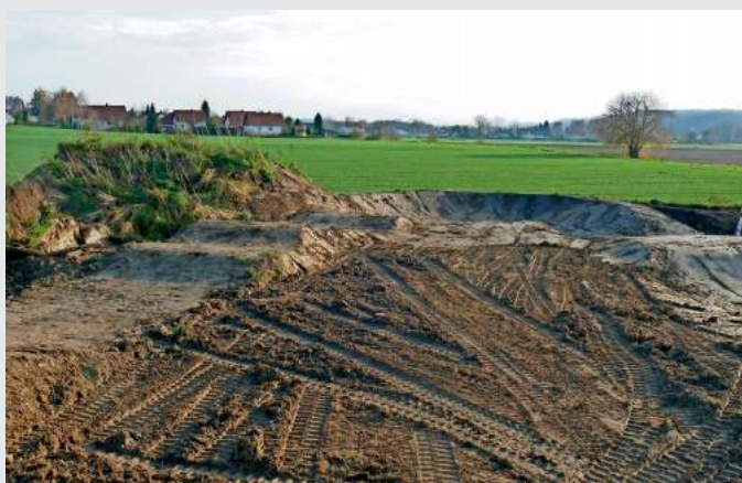
Die Bauarbeiten am Dirt-Park gehen voran...
