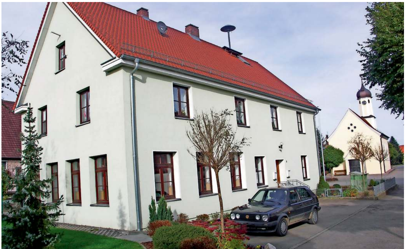
Soll grundlegend umgebaut werden: das ehemalige Schulhaus in Bühl
