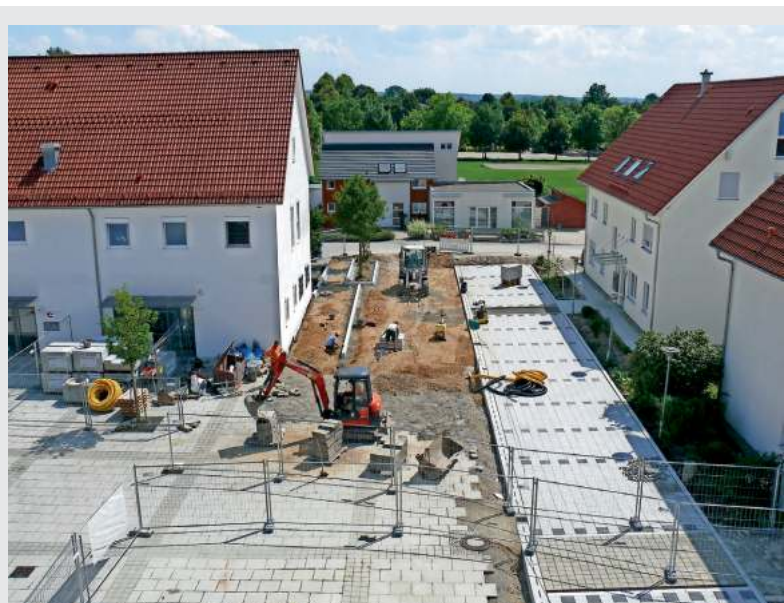
Die Sanierung des Rathausplatzes schreitet auch in den Ferien voran. Foto: Gemeindeverwaltung
